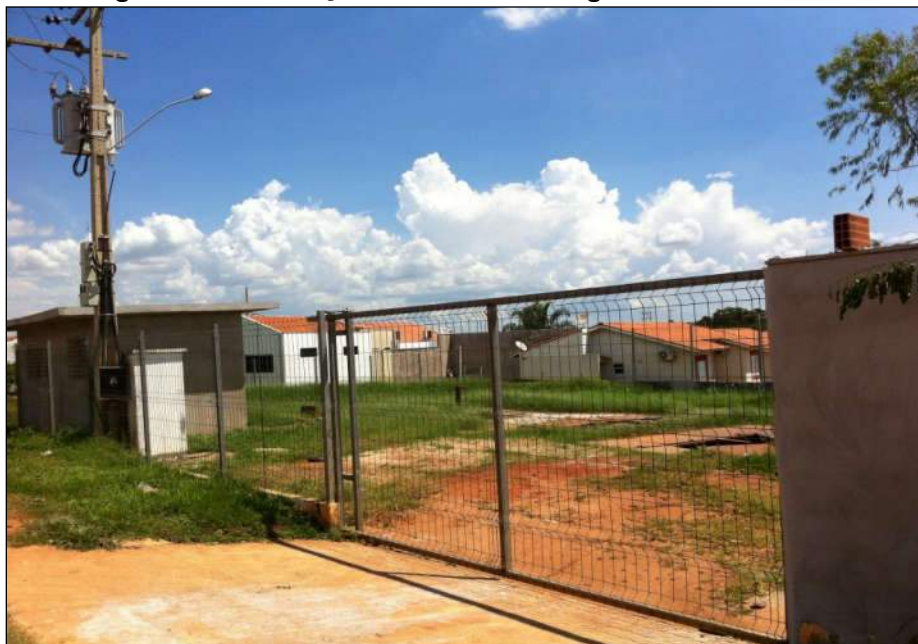
Figura 3.75 – Estação elevatória de esgoto - Colina Verde.
