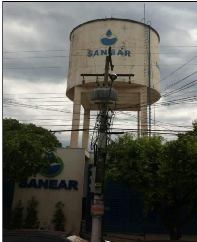
Figura 3.67 – Reservatório elevado desativado no centro.
