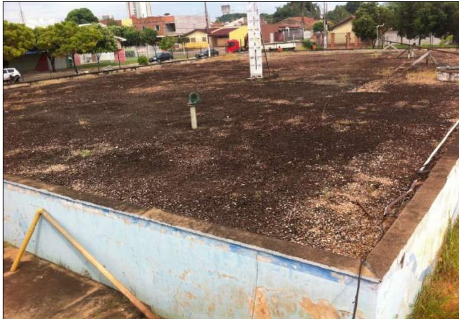
Figura 3.58 – Reservatório de água tratada.
