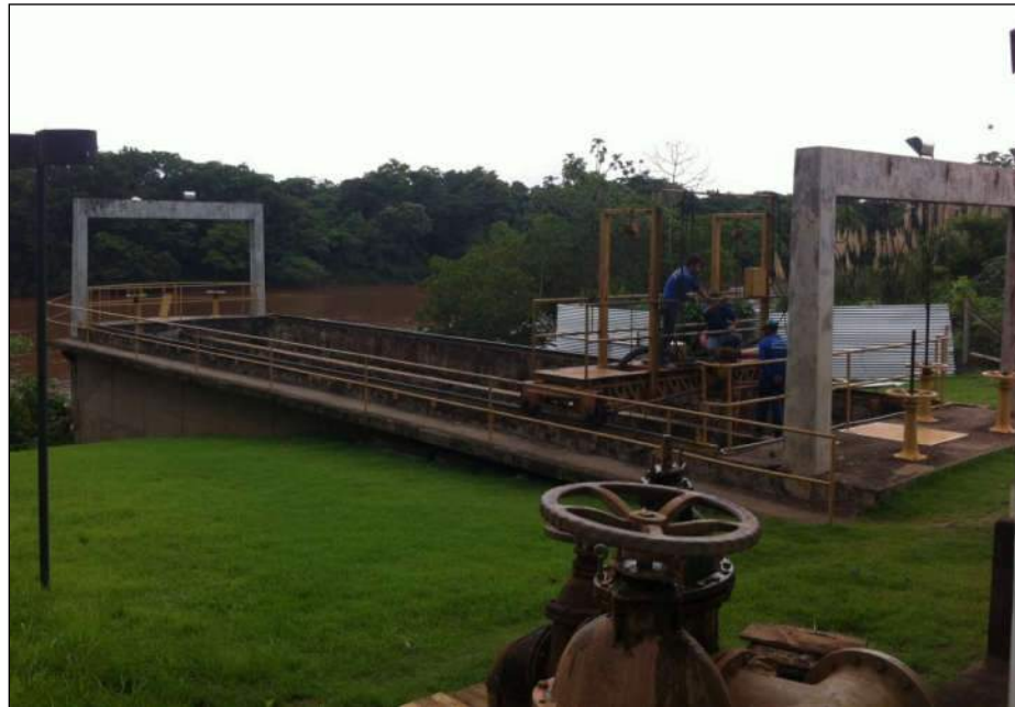
Figura 3.45 – Estação de captação de água superficial.
