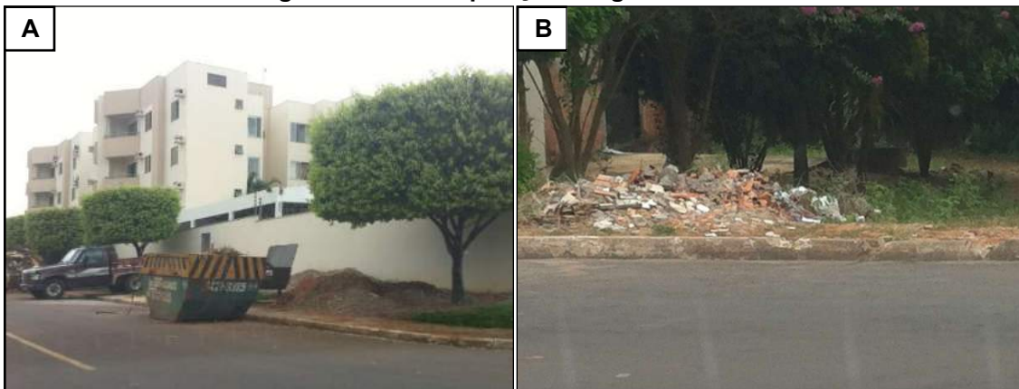
Figura 3.107 – Disposição irregular de RCC.
