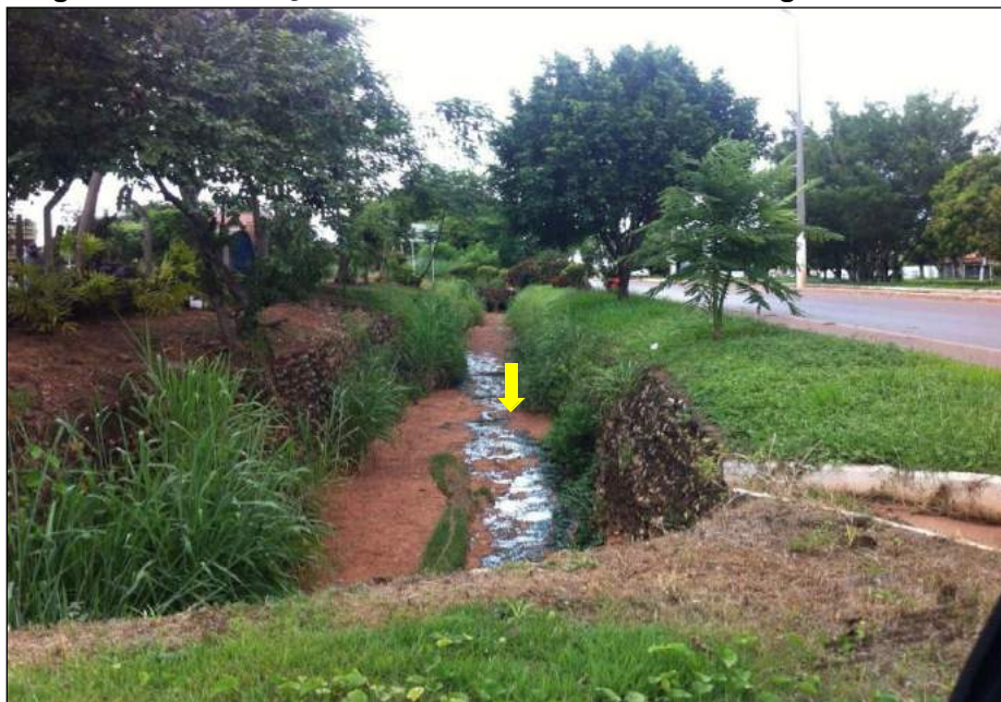
Figura 3.139 – Lançamento industrial na macrodrenagem da cidade.
