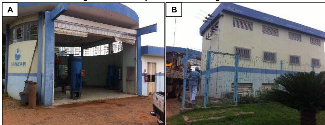
Figura 3.48 – Estação elevatória de água bruta.
