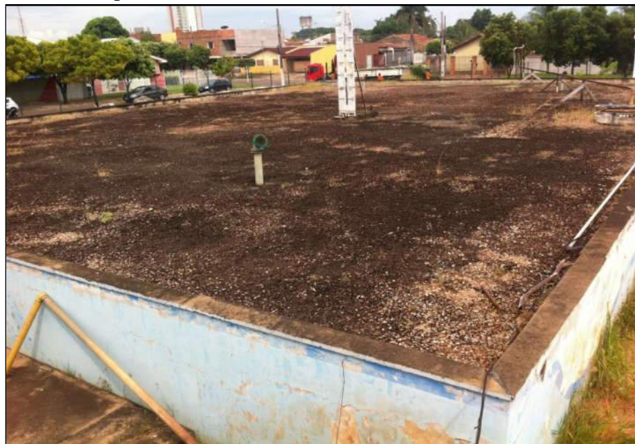
Figura 3.63 – Reservatório semienterrado na ETA I.
