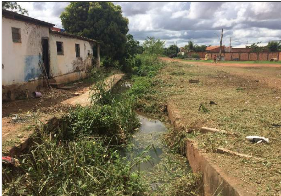
Figura 3.86 – Residências instaladas em áreas de fundo de vale.
