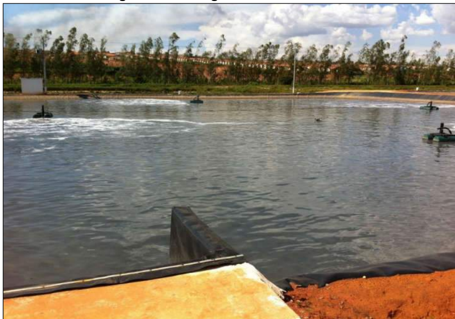
Figura 3.82 – Lagoa aerada facultativa.
