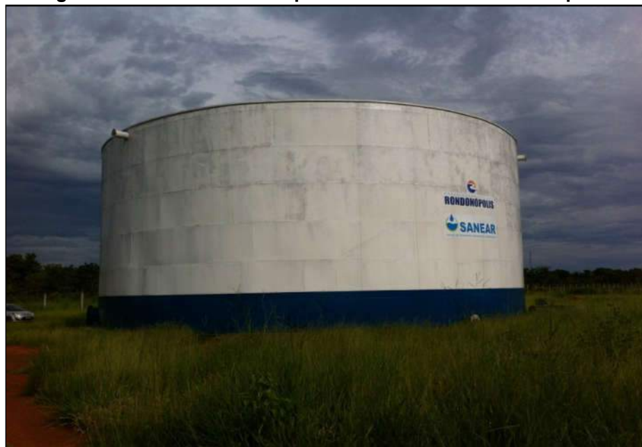
Figura 3.71 – Reservatório apoiado da UFMT em Rondonópolis.
