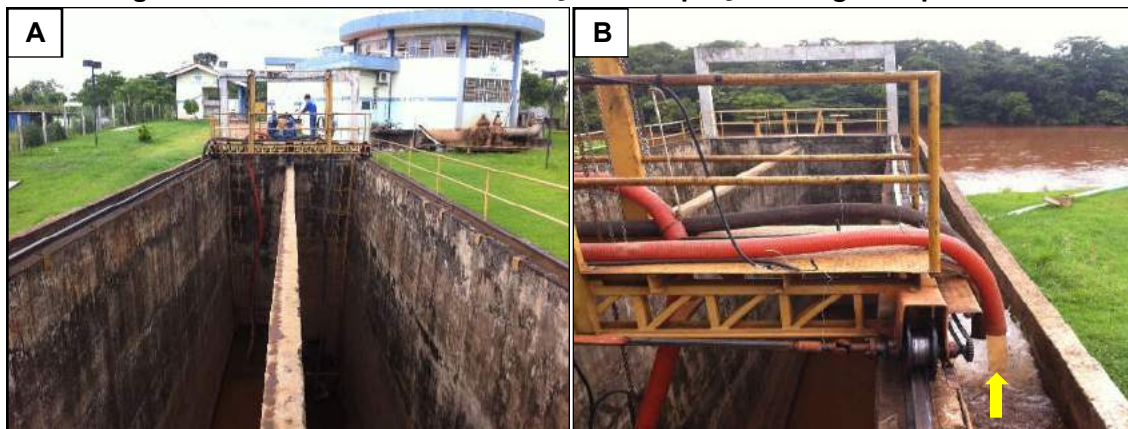
Figura 3.46 – Desarenador da estação de captação de água superficial.
