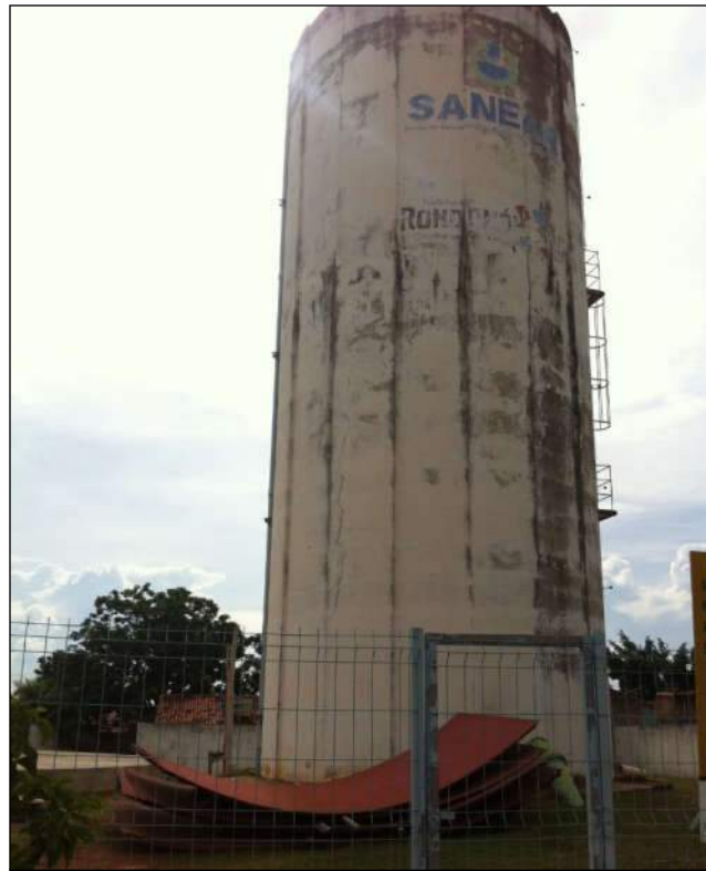
Figura 3.70 – Reservatório elevado do CR 3.
