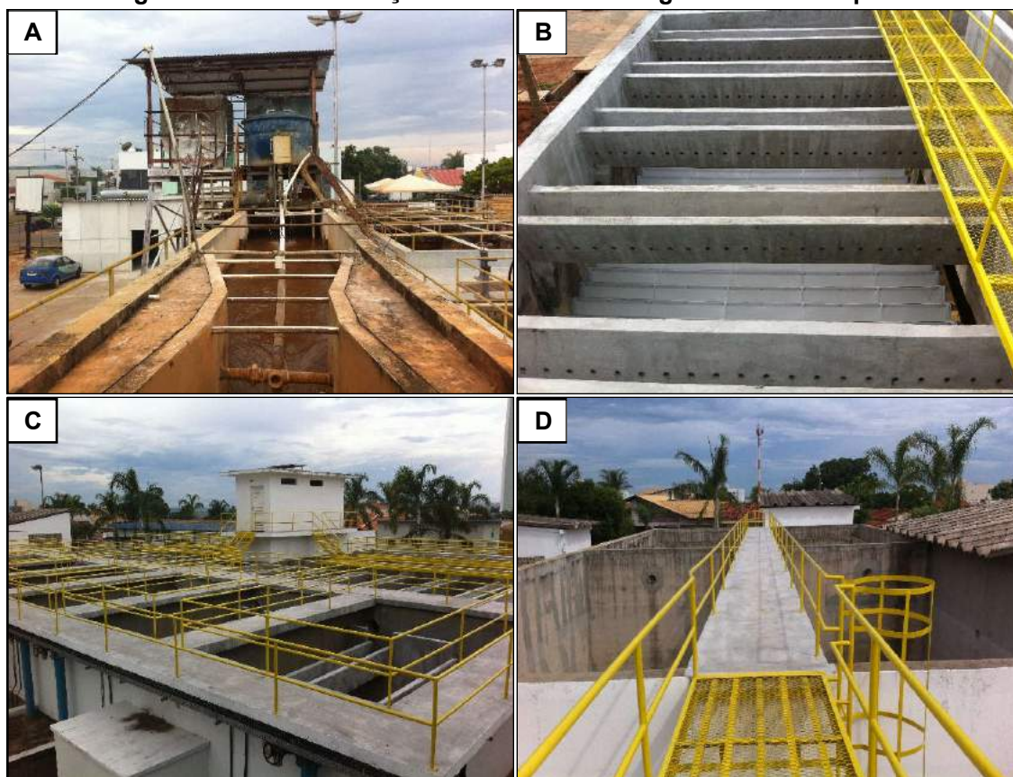
Figura 3.61 – Nova estação de tratamento de água de Rondonópolis.
