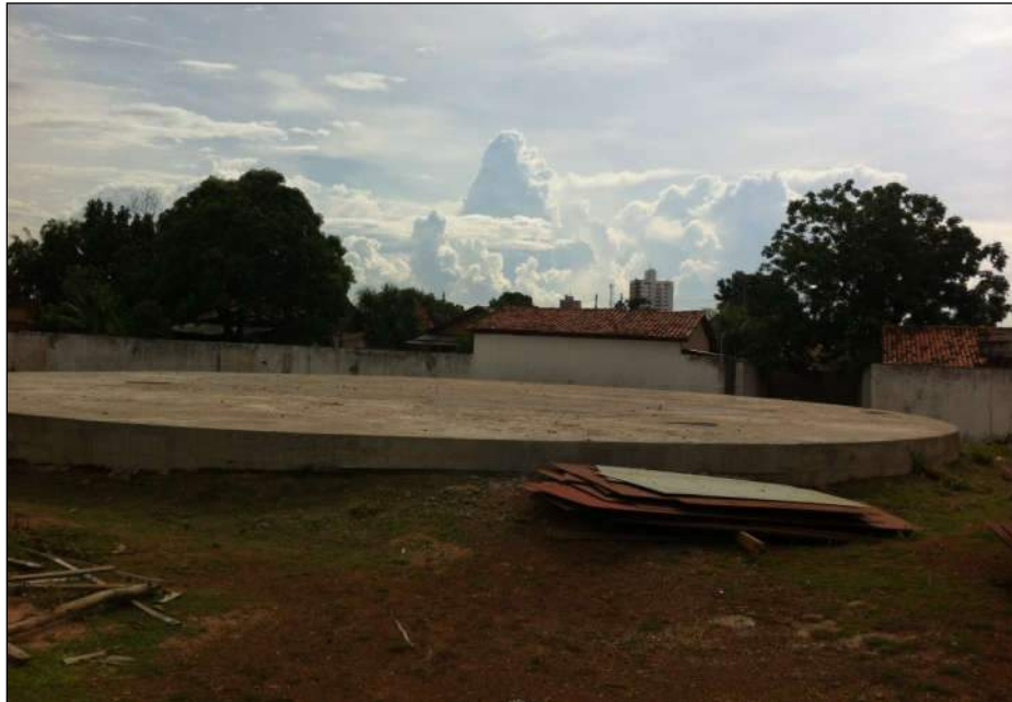
Figura 3.68 – Novo reservatório apoiado (em construção) - Cidade Alta.
