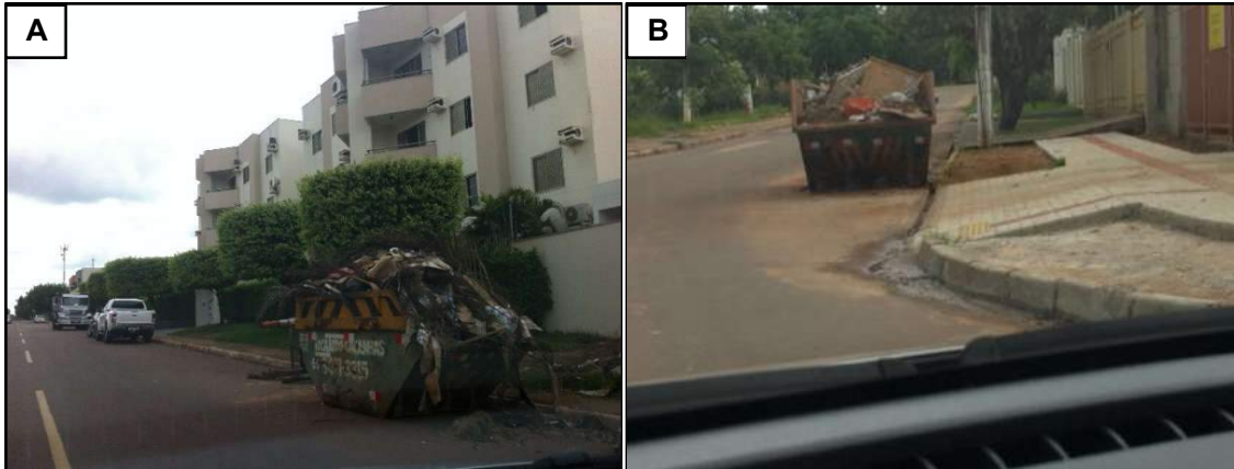
Figura 3.106 – Falta de segregação dos RCCs e dos resíduos comuns.
