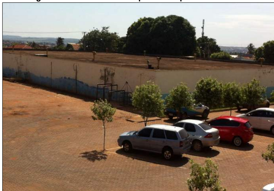
Figura 3.64 – Reservatório apoiado no pátio do SANEAR.
