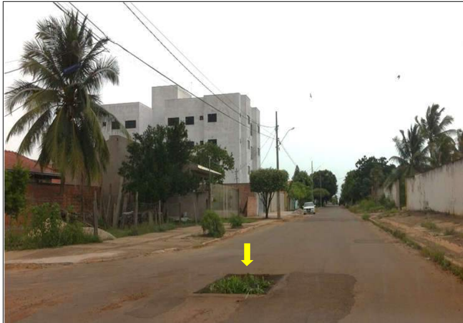
Figura 3.127 – Macro drenagem em bairros residenciais de Rondonópolis.
