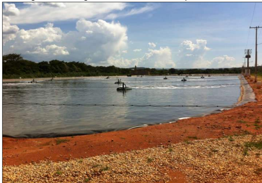
Figura 3.80 – Lagoa aerada de mistura completa - Linha 02.
