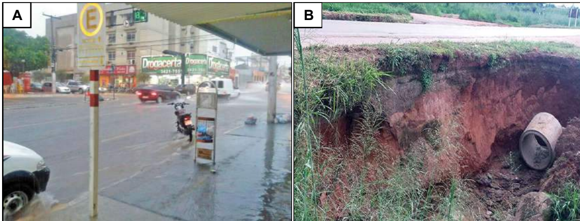
Figura 3.137 – Exemplos de alagamento e erosão em Rondonópolis.
