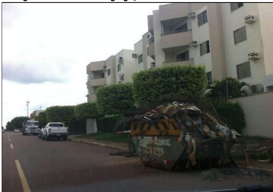
Figura 4.16 – Falta de segregação dos resíduos comuns e RCC.
