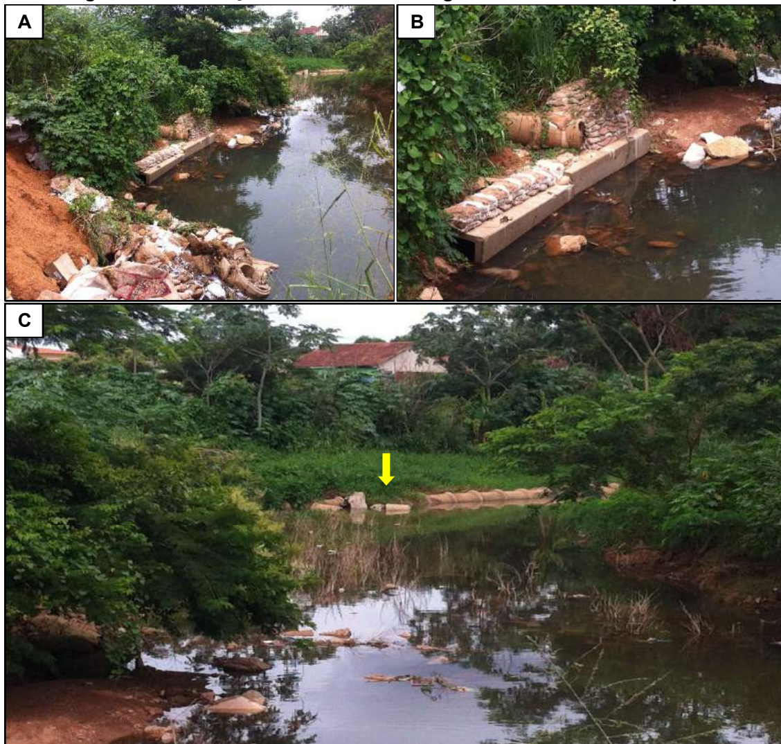
Figura 3.130 – Lançamento final de drenagem urbana em Rondonópolis.
